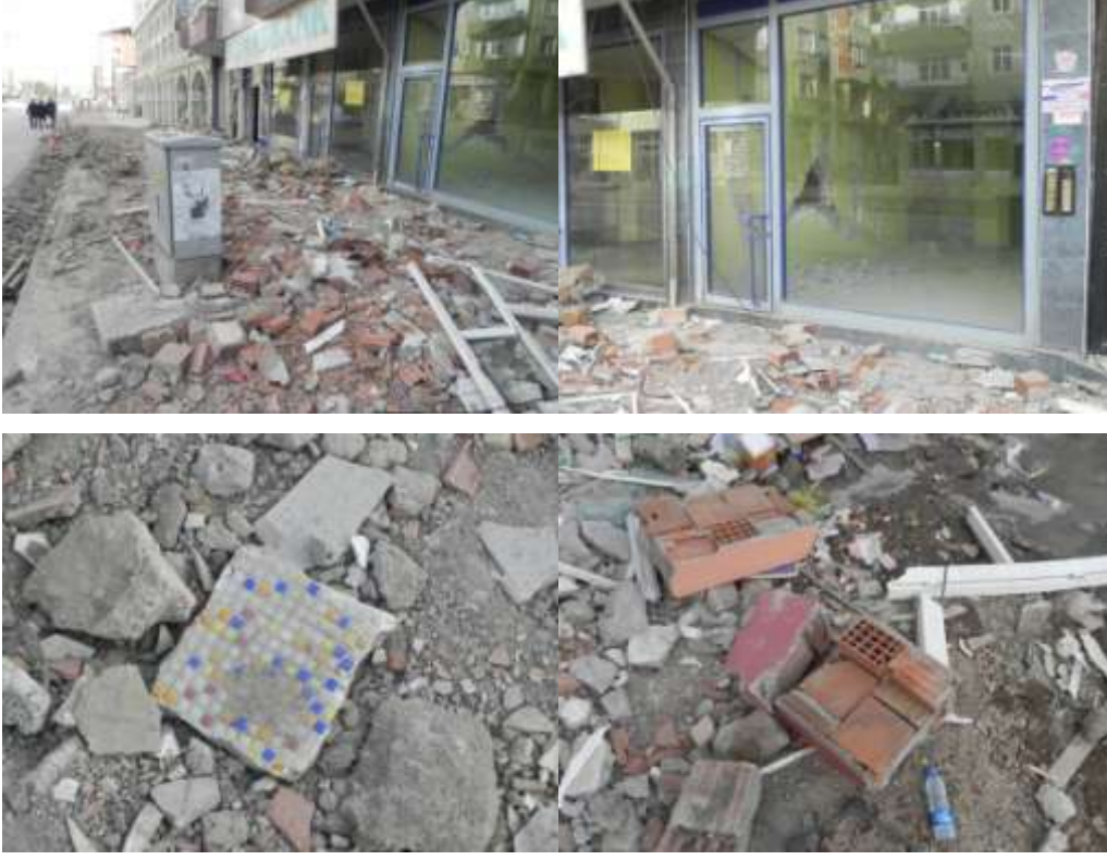
Resim 39. Deprem sırasında yapılardan kopan dolgu duvar ve cephe kaplama malzemelerinin yaya kaldırımlarına ve yollara düşmesi. Bu parçalar rahatlıkla bir insanın ağır yaralanmasına ya da hayatını kaybetmesine neden olabilecek büyüklükte olabilmektedir.
