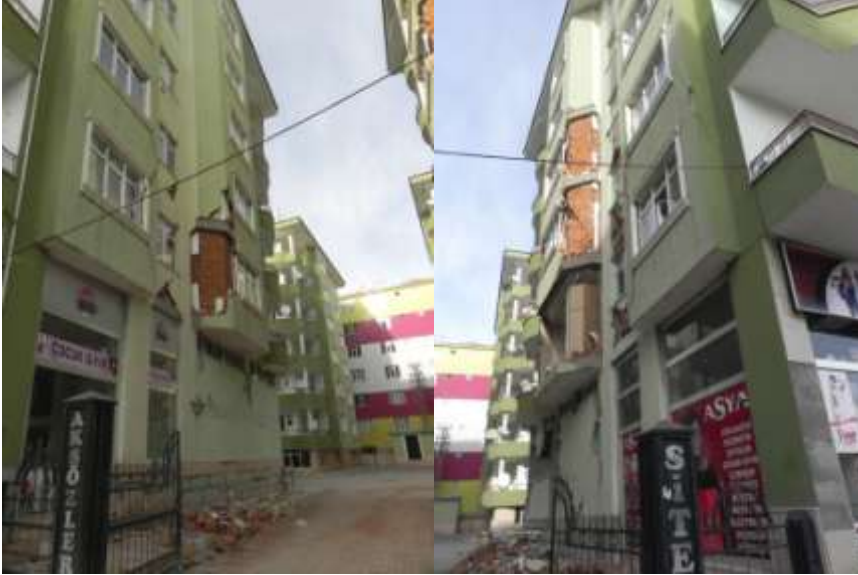
Resim 39. Deprem sırasında yapılardan kopan dolgu duvar ve cephe kaplama malzemelerinin yaya kaldırımlarına ve yollara düşmesi. Bu parçalar rahatlıkla bir insanın ağır yaralanmasına ya da hayatını kaybetmesine neden olabilecek büyüklükte olabilmektedir.
