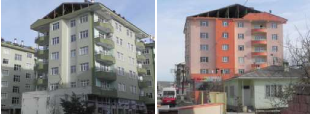
Resim 24. Tipik çatı parapet duvarı hasarları.
