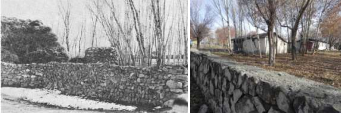
Resim 32. Soldaki resim 1976 Muradiye-Çaldıran (Van) Depreminde hasar görmemiş bir yığma moloz taş bahçe duvarı fotoğrafı. Sağdaki resim ise 2011 Tabanlı-Van Depreminde hasar görmemiş bir yığma bahçe duvarı. Muradiye-Çaldıran Depremi fotoğrafı Gülkan (ve diğerleri, 1978; s.33) den alınmıştır.
