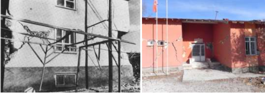
Resim 34. Soldaki resim 1976 Muradiye-Çaldıran (Van) Depremi'nde hasar gören tipik tek katlı yığma yapı fotoğrafı. Sağdaki resim ise 2011 Tabanlı-Van Depremi'nde hasar görmüş tek katlı yığma yapı. Muradiye-Çaldıran Depremi fotoğrafı Gülkan (ve diğerleri, 1978; s.54) den alınmıştır.
