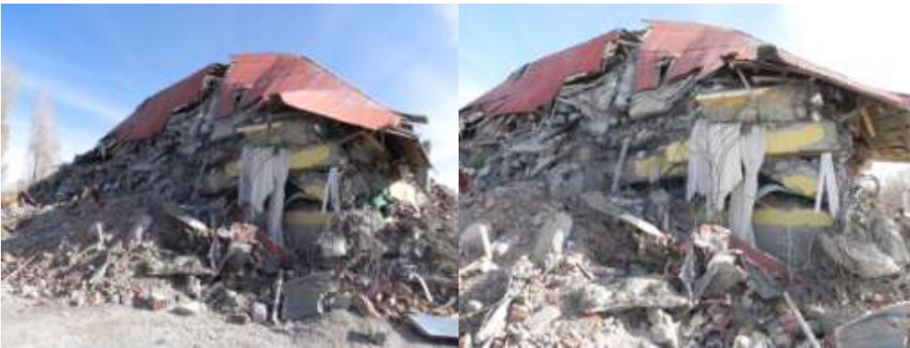
Resim 37. Tamamen göçen Gedikbulak İlköğretim Okulu.
