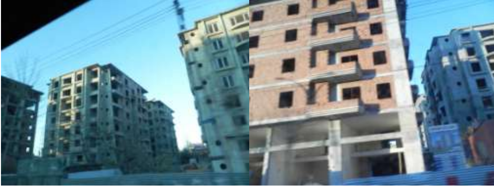
Resim 19. İnşaatı devam eden çok katlı betonarme binalar.
