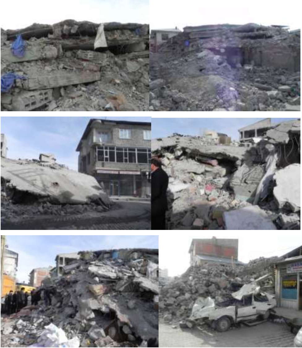
Resim 21. Tamamıyla göçmüş ve yapı taşıyıcı elemanları ayırt dahi edilemeyecek kadar un ufak olmuş binalar.
