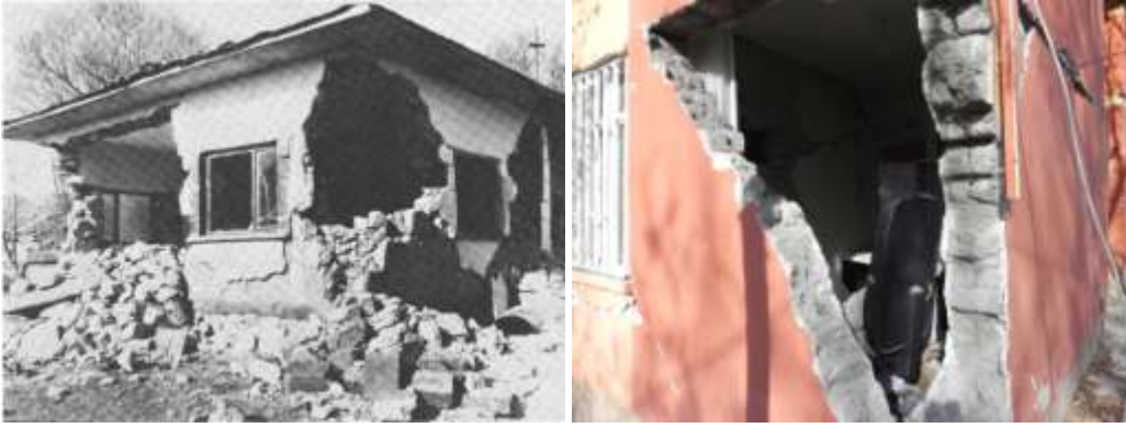
Resim 33. Soldaki resim 1976 Muradiye-Çaldıran (Van) Depremi'nde hasar gören tipik tek katlı yığma yapı fotoğrafı. Sağdaki resim ise 2011 Tabanlı-Van Depremi'nde hasar görmüş tek katlı yığma yapı. Muradiye-Çaldıran Depremi fotoğrafı Gülkan (ve diğerleri, 1978; s.53) den alınmıştır.
