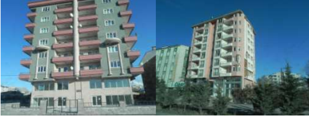
Resim 18. Van ve Erciş’te kent merkezinde karşılaşılan tipik betonarme çerçeve binalar.
