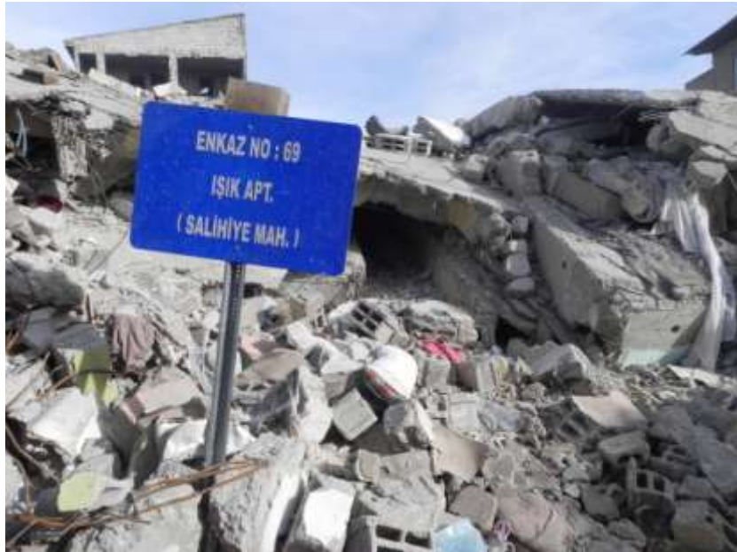
Resim 4. Erciş'te bir bina enkazı ve önünde enkazın hangi binaya ait olduğunu gösteren tabela.
