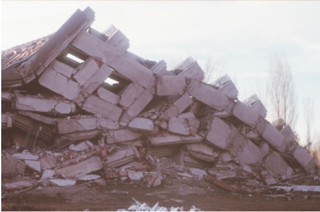
Şekil 10. Çay ilçesi güneyindeki sıvılaşma kapasitesi yüksek zemin üzerinde kurulu tümüyle yıkılmış 9 katlı betonarme binanın yakın görünümü.
