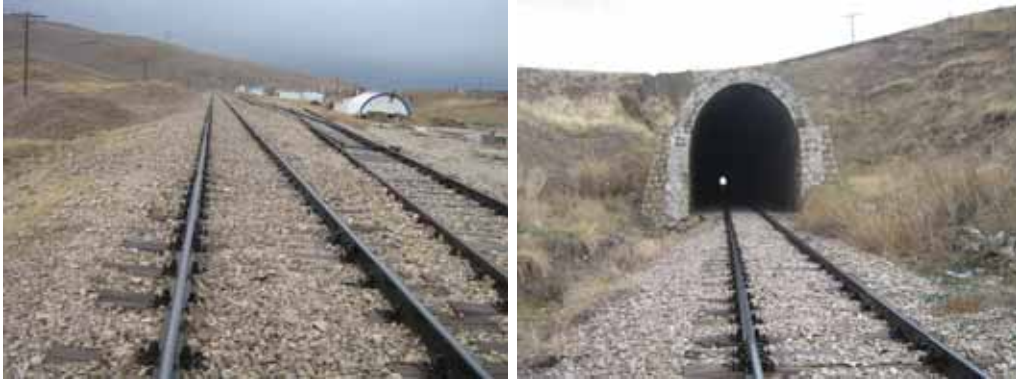
Şekil 4.5. Hasar görmemiş demiryolu hattı ve demiryolu tüneli.
