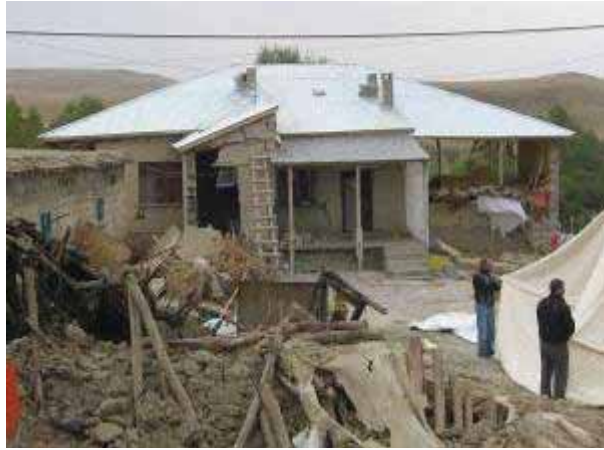
Şekil 3.28. Fotoğrafın alt kısmında toprak damlı göçmüş yığma yapı, fotoğrafın üst kısmında ise ağır hasarlı ancak ayakta duran hafif çatı malzemesi kullanılmış yapı.
