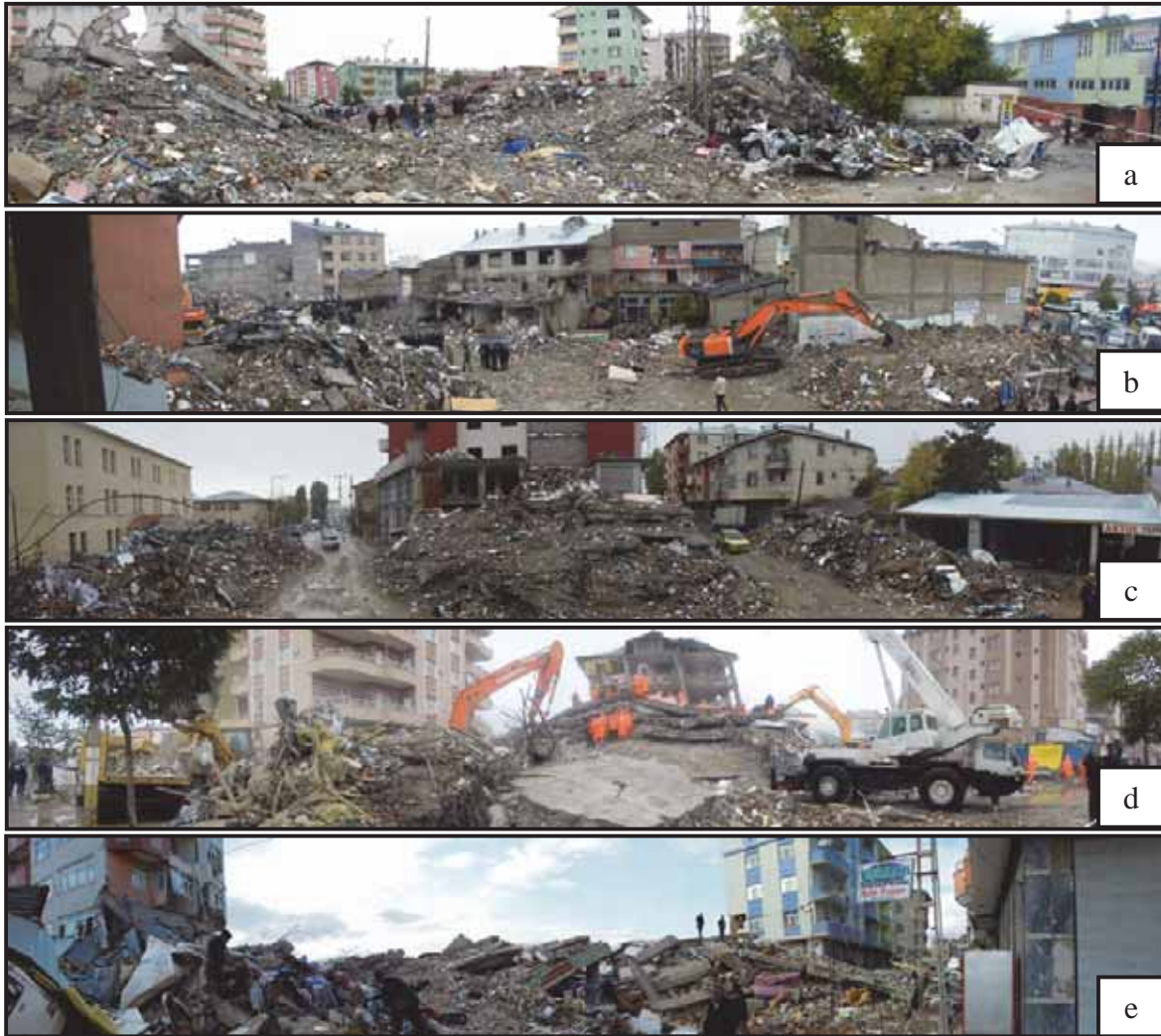
Şekil 3.1. Tamamen göçüp enkaz haline gelen binalar.
