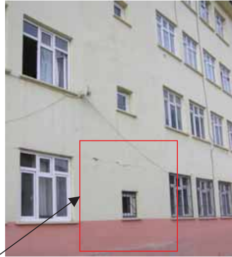
Güçlendirme için ilave Edilen Perdede Arayüz Çatlakları
