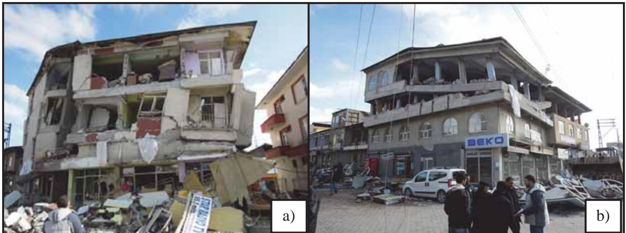
Şekil 3.4. Zayıf kat üzerine yıkılan binalar.
